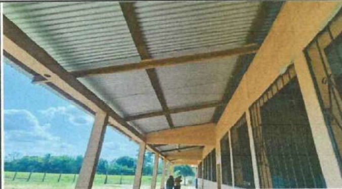
Foto 2: SUSTITUCION DE ESTRUCTURA DE MADERA POR ESTRUCTURA METALICA
