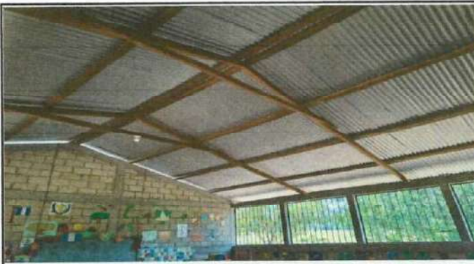
Foto 4: SUSTITUCION DE ESTRUCTURA DE MADERA POR ESTRUCTURA METALICA
